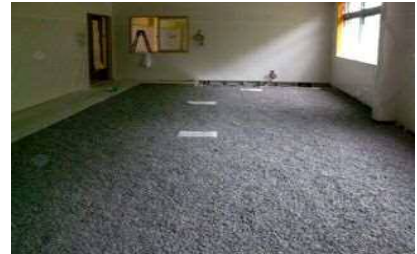
事務所に(施工写真)
