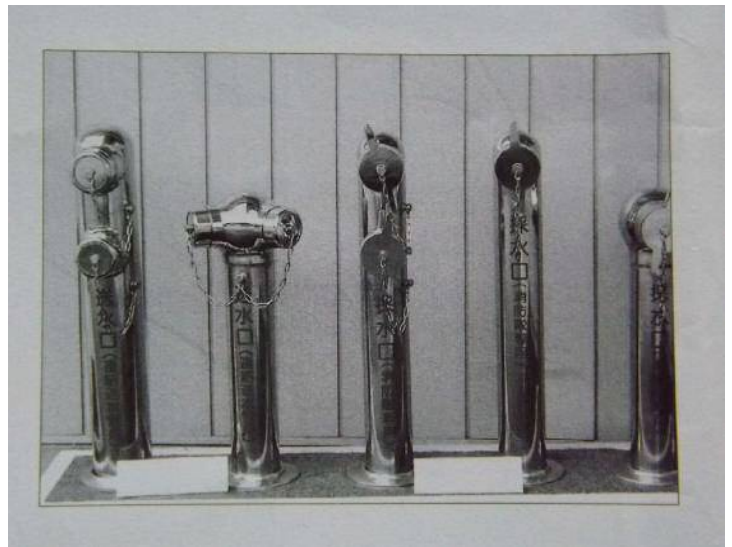
中高層建築物に使用する送水口、採水口
